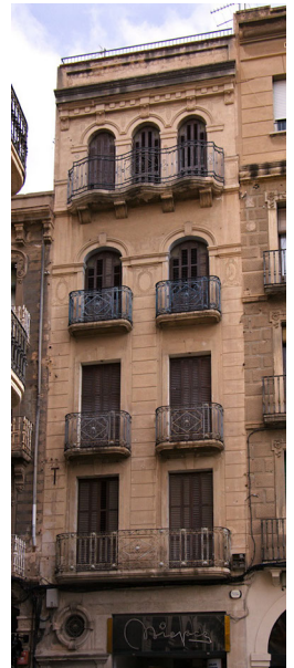
REUS_EDIFICI CARRER LLOVERA 11_Amadalvarez
