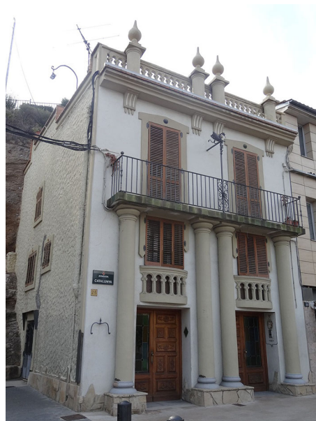
LA POBLA DE CLARAMUNT_FAÇANA AL CARRER ...
